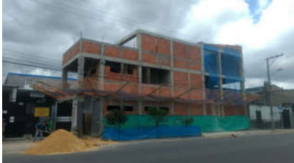
Instalaciones en construcción
