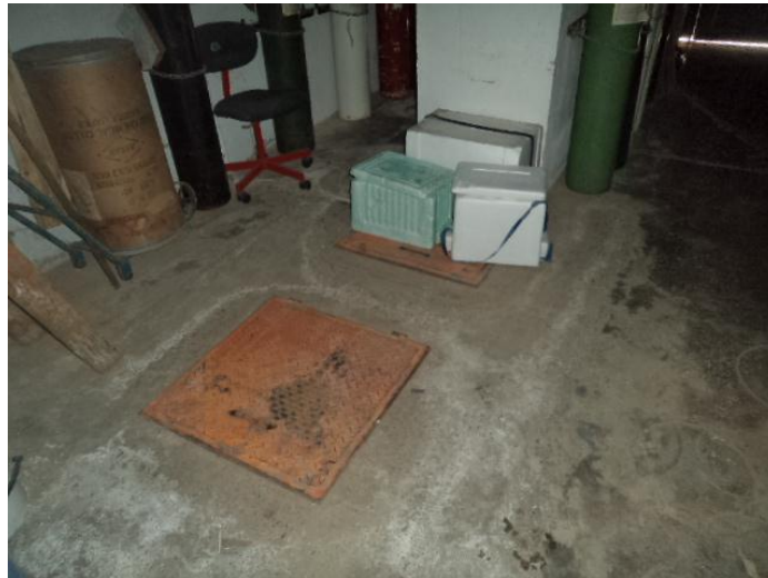
Ilustración 9 Tanques de Tratamiento
