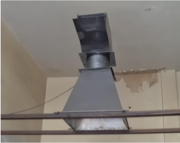
Ilustración 1 Campanas Extracción
